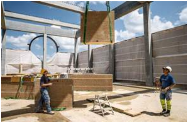
Fassadenbau im künftigen Kräutlerlager
