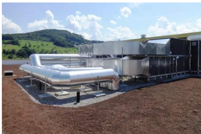
Hohe Anforderungen an die Luftqualität: Lüftungsmonoblock
