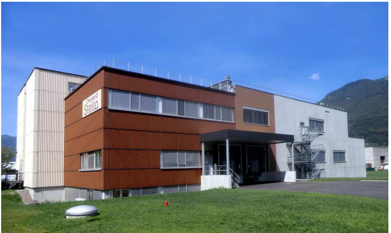
Produktionsstätte der Chocolat Stella SA mit dem Erweiterungsbau in Giubiasco TI
