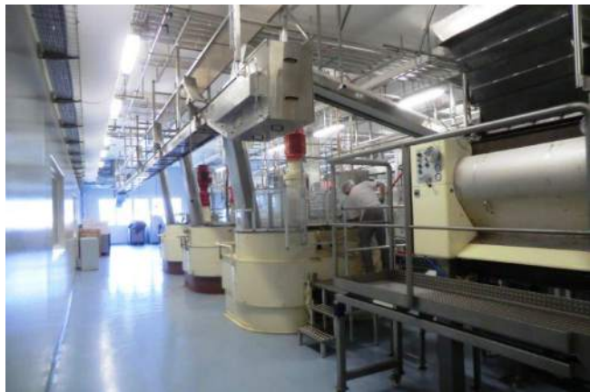
Conchen im neuen Erweiterungsbau
